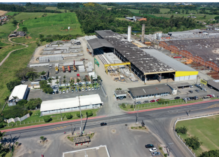
Sede Centrale della BPM
